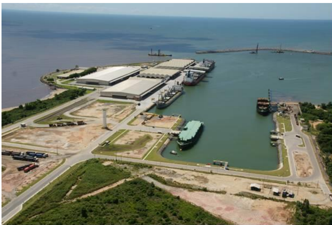
Figura 4.4 - 1: Vista aérea do Porto de Barra do Riacho destacando-se o Terminal de Portocel e o do Terminal de Barcaças - recebimento de toras de eucalipto e celulose em fardos.
